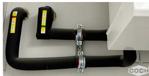
Rys. 6. Przykład rurociągów czynnika chłodniczego (źródło: [10])
